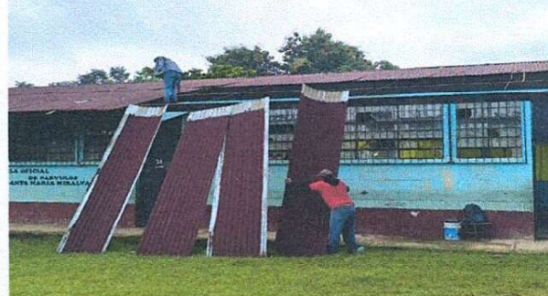
Foto 2: Desistacion de la estructura del techo de la escuela
