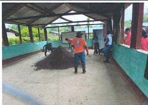
Foto 3: Proceso reparación del piso del aula.
