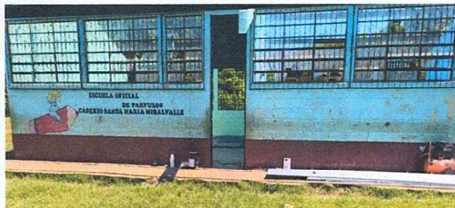
Foto1: Proceso de reparación de pintura.
