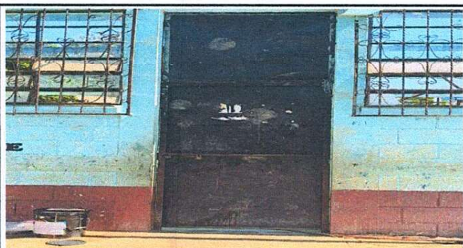
Foto 5: Proceso de cambio y mejoramiento de puerta.
