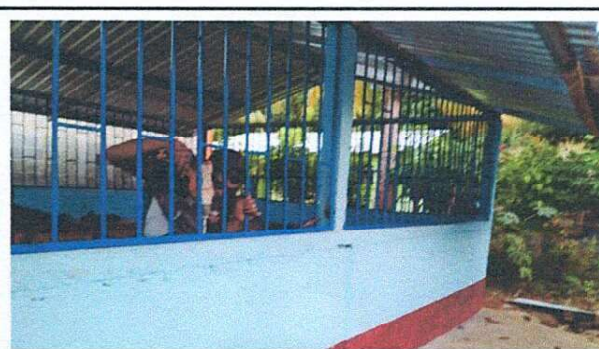
Foto 6: Reinstacion de balcones del aula.
